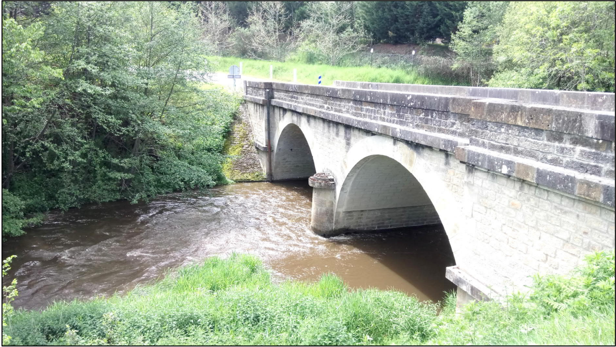
Figure 75 - La Benaize au passage sous la RD 29
