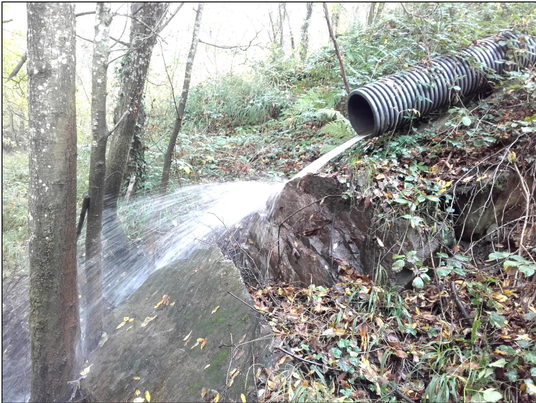
Figure 83 - Point de rejet, après décantation, des eaux d'exhaure dans la Benaize
